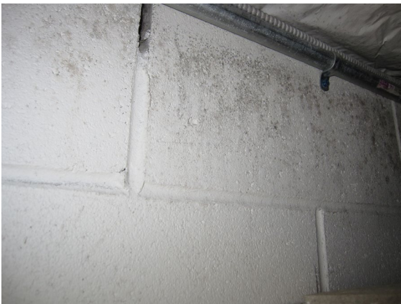
Figura 1-2 Crecimiento de moho en mampostería de concreto pintado. El muro de concreto frío separa un salón de clases de una pista de hielo. El aire húmedo en el salón de clases provee la humedad que se condensa en la superficie pintada de la mampostería. Esa humedad permite que el moho crezca en la capa de pintura.
