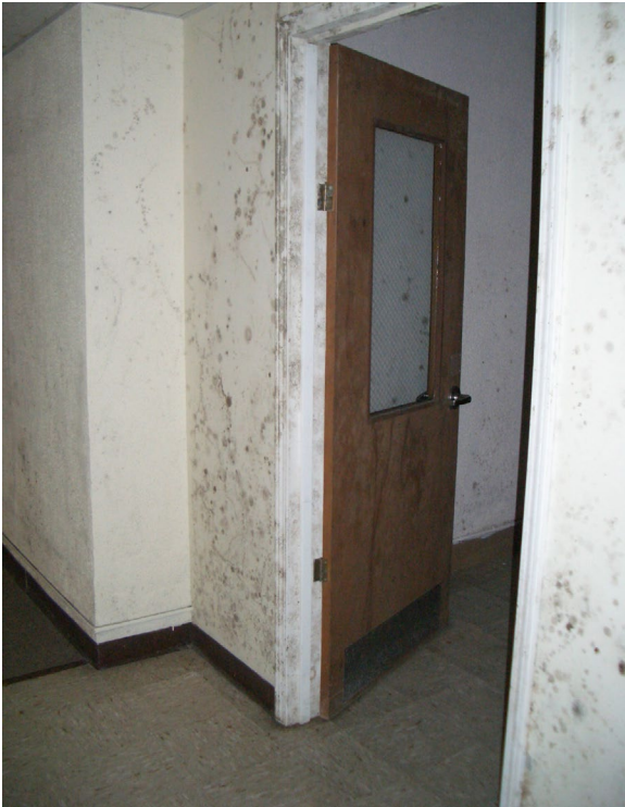
Figura 1-1 Moho creciendo en la superficie de paneles de yeso y remates pintados. La alta humedad por largo tiempo es la fuente de humedad que permite el enmohecimiento. Todos los muros tuvieron condiciones similares cercanas a la condensación. Consecuentemente, el enmohecimiento es más bien generalizado que concentrado en una sola área de humedad excesiva.
