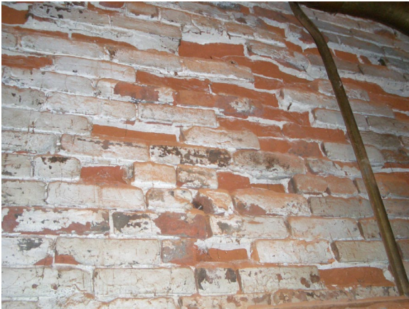
Figura 1-14 Daño en los ladrillos causado por el paso de sal soluble a través de ellos. Las sales en los ladrillos o lechada se disuelven en agua de lluvia que se absorbe a través de los ladrillos. El agua se evapora en el interior de la edificación y la sal que se queda se cristaliza y separa la capa de la superficie del ladrillo, exponiendo su interior. Este proceso se llama sub-fluorescencia.
