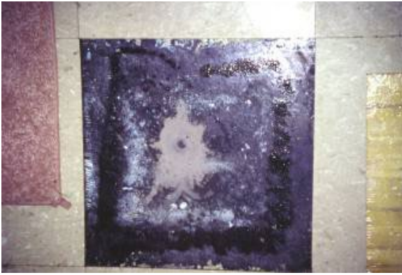
Figura 1-13 Adhesivo de baldosas que no secó a causa de agua en el concreto y los niveles altos de pH. Las baldosas pueden quitarse con la mano. El piso es una losa de concreto a nivel del suelo. El agua visible en la foto se evapora en el cuarto después de algunos minutos. Su origen puede ser agua en estado líquido absorbiéndose desde debajo del relleno de la sub-losa o vapor de agua desplazándose a través de la losa.
