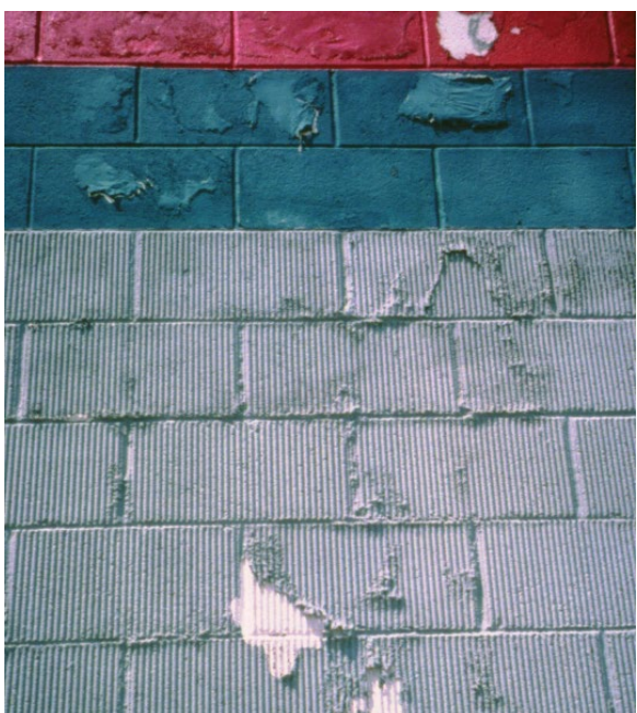
Figura 1-6 Pintura ampollada en bloques de concreto caravista. La lluvia arrastrada por el viento es la causa de la humedad que contribuye al daño. El agua se absorbe en el bloque de cemento (CMU) a través de agujeros muy pequeños en la pintura. El sol provoca que vapor de agua pase a través del CMU. El ensamblado no puede secarse al interior por la baja permeabilidad de vapor del tablero de espuma de plástico que, encintado en las uniones, aísla la superficie interior del muro. El muro se mantiene saturado durante la primavera, el verano y el otoño. La misma pintura en áreas del muro en donde no le pega el sol ni la lluvia no muestra daños.
