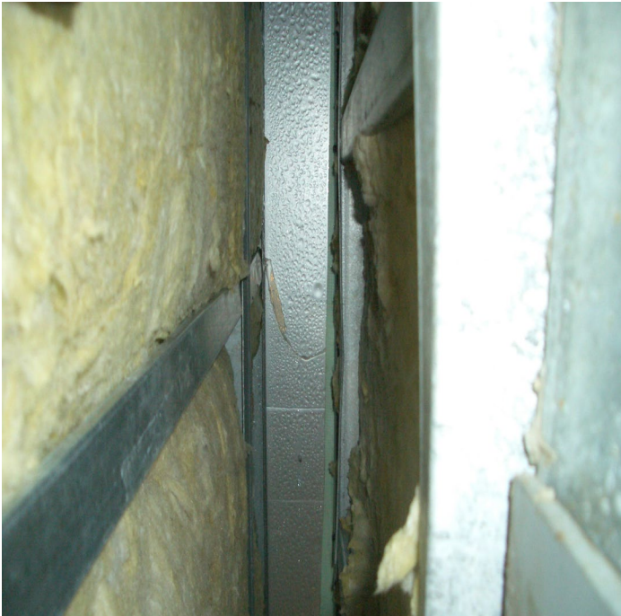
Figura 1-20 Condensación en Estructuras Metálicas Sin Aislamiento en Climas Fríos
