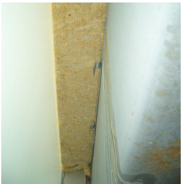
Figura 1-5 Corrosión del acero estructural en una cavidad de cielorraso en un clima frío. El acero se extiende hacia el ensamblaje del muro exterior. Durante el clima frío, el acero cerca del muro se enfría por efecto del aire exterior. La edificación se humedece y condensación de la elevada humedad interior provee la humedad que corroe el acero frío.
