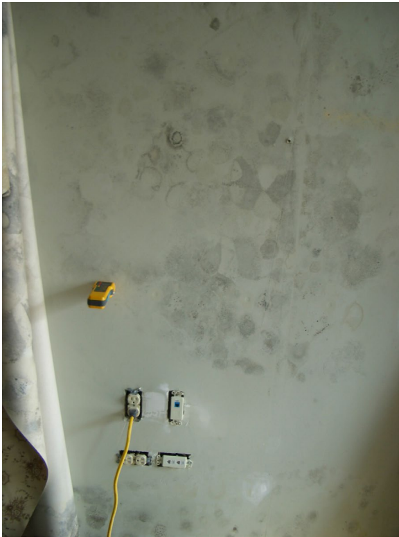
Figura 1-7 Condensación detrás del papel tapiz de vinilo en un clima caliente y húmedo. La condensación y el enmohecimiento ocurren detrás del papel tapiz de vinilo en ambos muros interiores y exteriores. Las fugas de aire en el pleno de retorno de la manejadora de aire despresurizan las cavidades interiores y exteriores del muro. El aire exterior cálido y húmedo del exterior se tira a través de fugas de aire en un muro pesado de mampostería.
