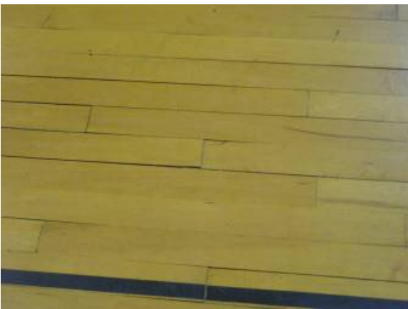
Figura 1-12 El piso de madera de un gimnasio se pandeó a causa de la humedad en la cavidad debajo de éste. El agua sube a través del bajo piso de concreto. El origen de la humedad es el agua de lluvia que no ha sido drenada de la fundación de la edificación.
