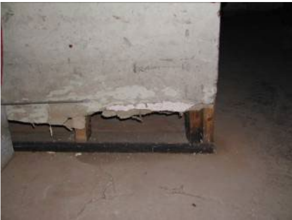
Figura 1-11 El panel de yeso en el borde inferior de un muro de sótano se disolvió a causa de aguas de inundación de temporal. La cama de agua está justo abajo del piso del sótano durante el cima seco y sube varias pulgadas por encima del piso durante las lluvias intensas de la primavera.
