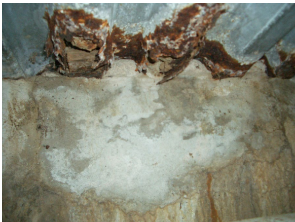
Figura 1-4 Corrosión de la plataforma de piso de acero galvanizada acanalada. El piso está a nivel del suelo. El agua proviene de la filtración de agua de lluvia.
