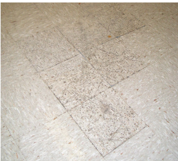
Figura 1-3 Crecimiento de moho en baldosas de piso de vinilo. La alta humedad por largo tiempo proveyó la humedad que fue absorbida en la baldosa de vinilo fría y permitió el enmohecimiento. También nótese que la alta humedad causó la falla del adhesivo que fija la baldosa al piso, permitiendo que la baldosa quedara suelta.
