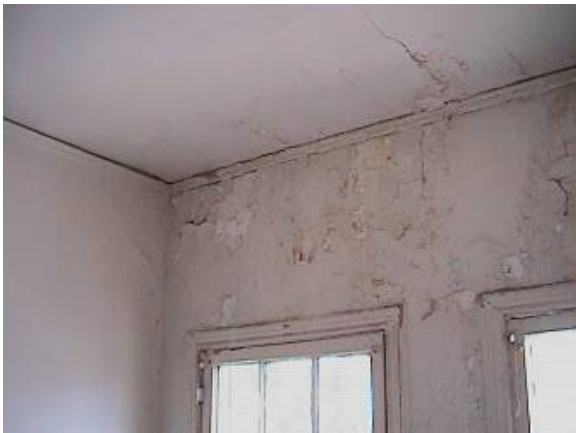
Figura 1-8 Fugas de agua en un muro de parapeto de techo resultan en daños en el revoque y en pintura despegada. El agua de lluvia es introducida de este ensamblaje de ladrillos por acción capilar, y la humedad camina hacia abajo por la fuerza de gravedad. La pintura despegada contiene plomo y provoca un medio ambiente peligroso así como daños físicos al revoque.
