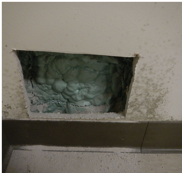
Figura 4-1 Muro Interior Mostrando Daños por Agua y Moho
