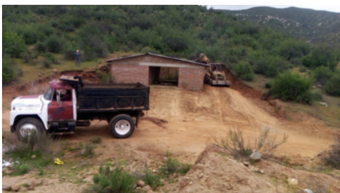
Inicio de trabajos de nivelación de la zona nivelada
