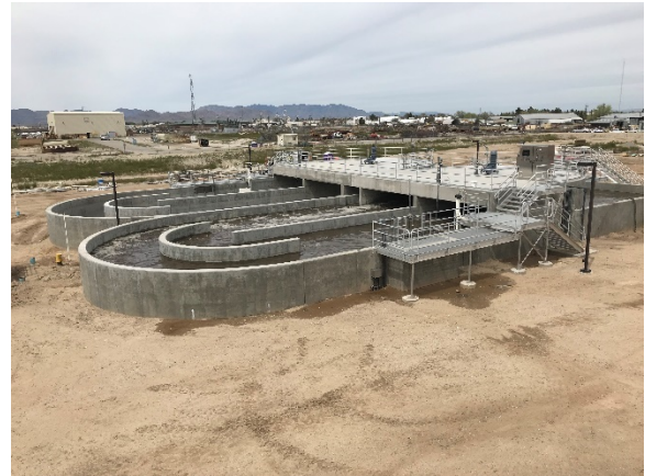
Zanjas de oxidación de la nueva construcción en Willcox WWTP
