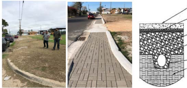
Fotos del antes y después de esta zona de alta prioridad, incluyendo el diseño de ingeniería de la sección transversal del pavimento permeable.
