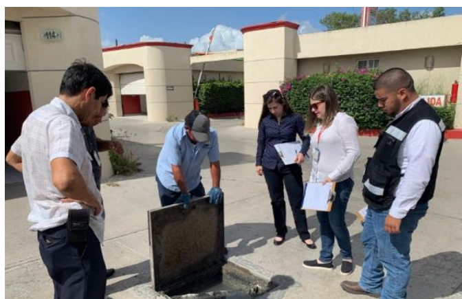
Ilustración 4. Inspección del hotel Crown
